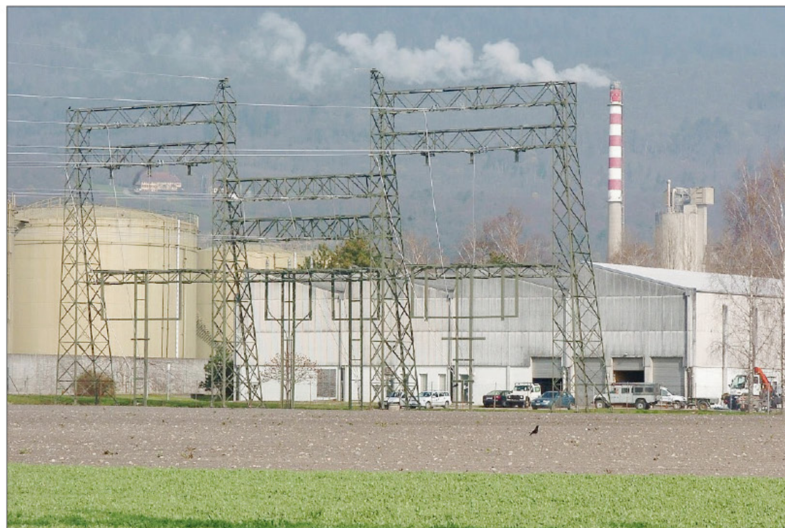
CORNAUX C'est sur le site de l'actuelle usine électrique du Groupe E que devrait s'ériger la centrale à gaz tant controversée.
